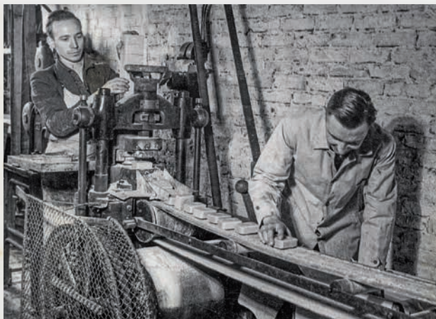
Seifenfabrik anno dazumal: Die ausgestanzten Seifenstücke wurden an einer Spezialmaschine gestempelt.
